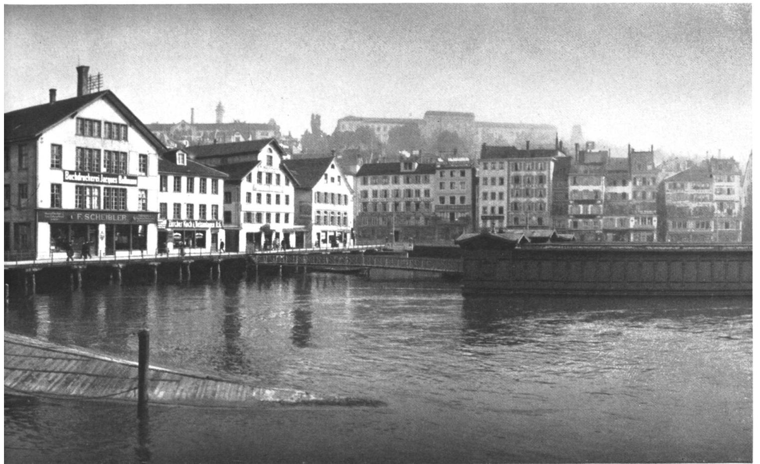
Der untere Mühlsteg in Zürich, wie er um 1900 — und bis in die 1950er Jahre hinein — aussah: das gedeckte Brüggli, rechts dahinter das Globus-Gebäude und weitere Geschäftshäuser. Der Eidgenössischen Technischen Hochschule fehlt noch die Kuppel, und völlig fehlt die um 1914 erbaute Universität.
