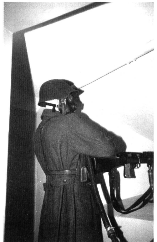
Eingebauter Maschinengewehrstand. Ueber den Schlauch wird gefilterte Frischluft zugeführt.
