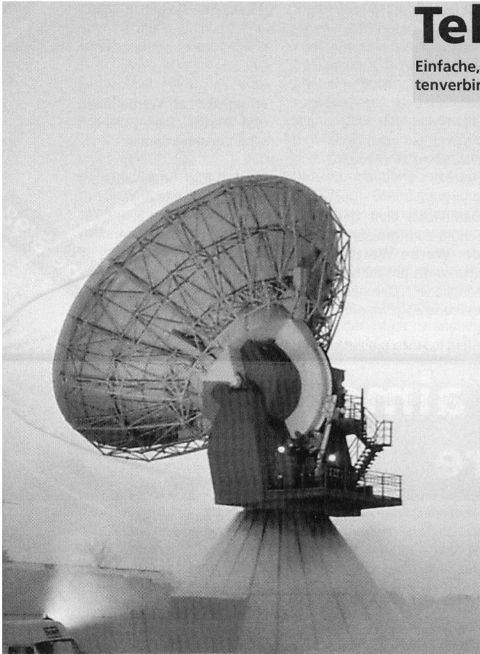
Eine der Bodenstationen, die die Verbindung zwischen den INMARSAT-Satelliten und dem öffentlichen Telefonnetz aufrechterhalten.
