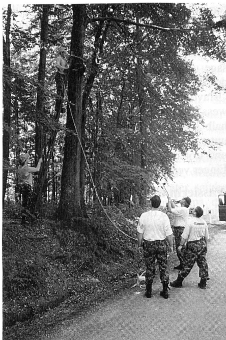
Ein Teil des Bautrupps ist mit dem F20-Hochbau beschäftigt
