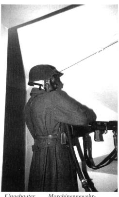
Eingebauter Maschinengewehrstand. Ueber den Schlauch wird gefilterte Frischluft zugeführt.
