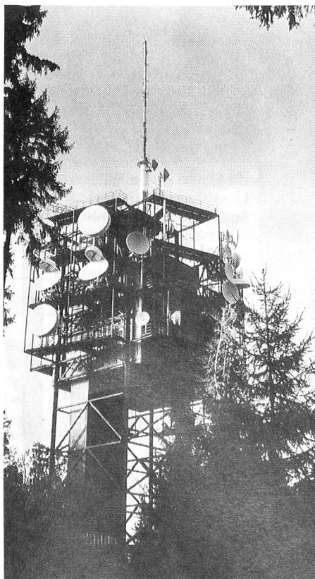
Der für die meisten Berner nicht unbekannteste Mast auf dem Ulmizberg ist ein wichtiger Baustein im nationalen Basisnetz.
