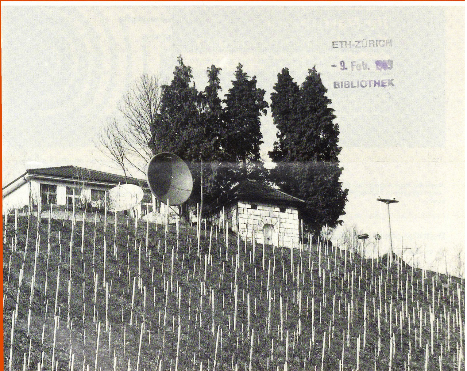
Grossgemeinschaftsantennenanlage Rheinau (Foto: R. Kilchmann)
