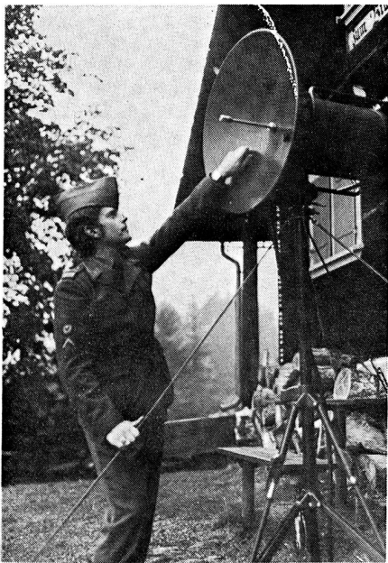
Montage und Ausrichtung des Richtstrahlgerätes, mit dem eine Telefon- und Fernschreibverbindung vom Oberseetal nach dem Chäserugg im Toggenburg hergestellt wurde.
