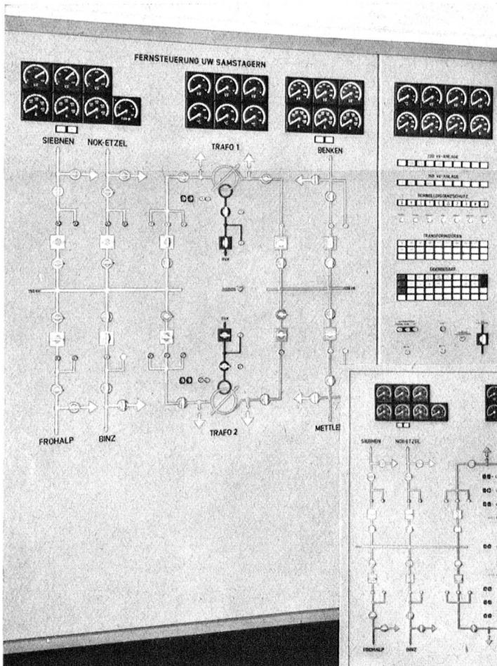
Von dieser Schalttafel aus wird in Zürich über eine ALBIS-Fernsteuerungs-Anlage das Unterwerk Samstagern ferngesteuert.
