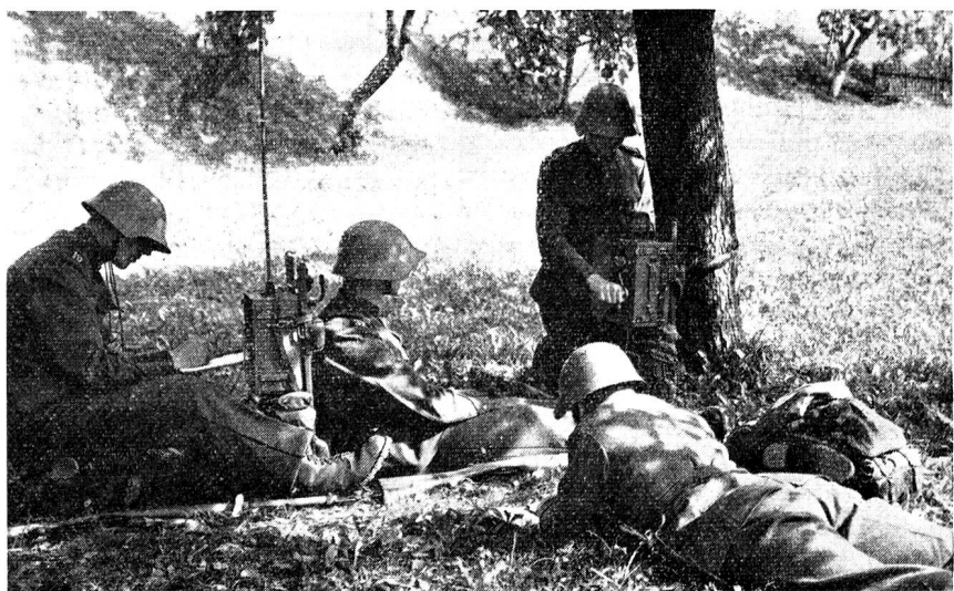
Die erste Funkstation der Infanterie, vorab als Patrouillengerät eingesetzt.
