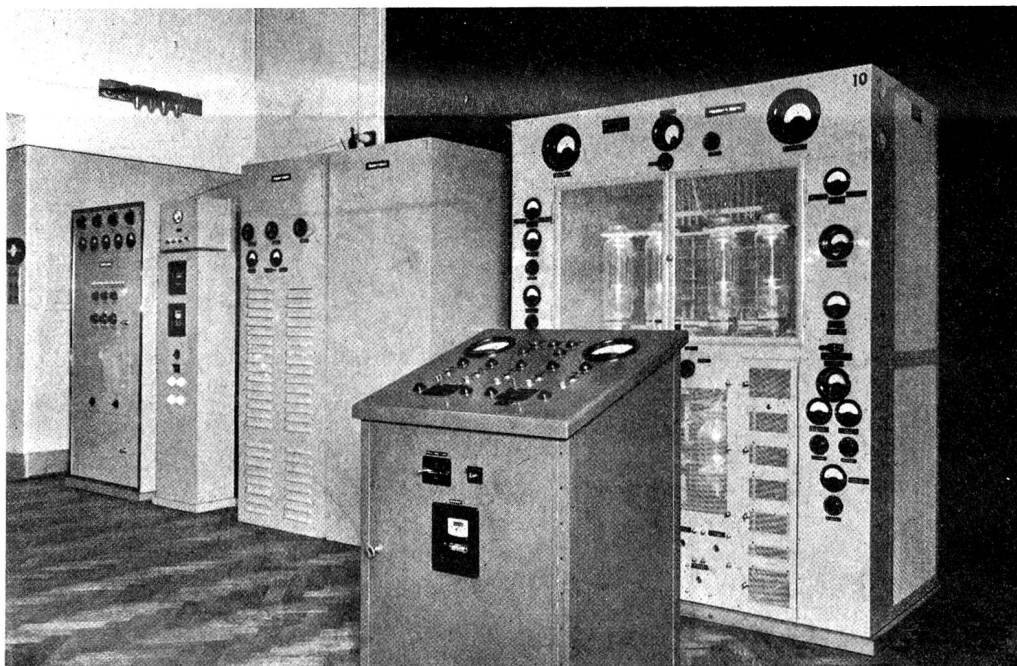
Das Bild zeigt: links einen Nahzonen-Sender für den zivilen Flugverkehr, rechts einen Kurzwellen-Telegraphie-Sender für den Verkehr mit Übersee
