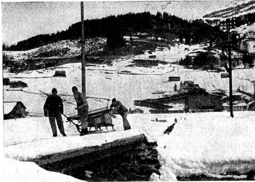
Materialtransport auf dem «Kabelschlitten» nach Gerschnialp.
