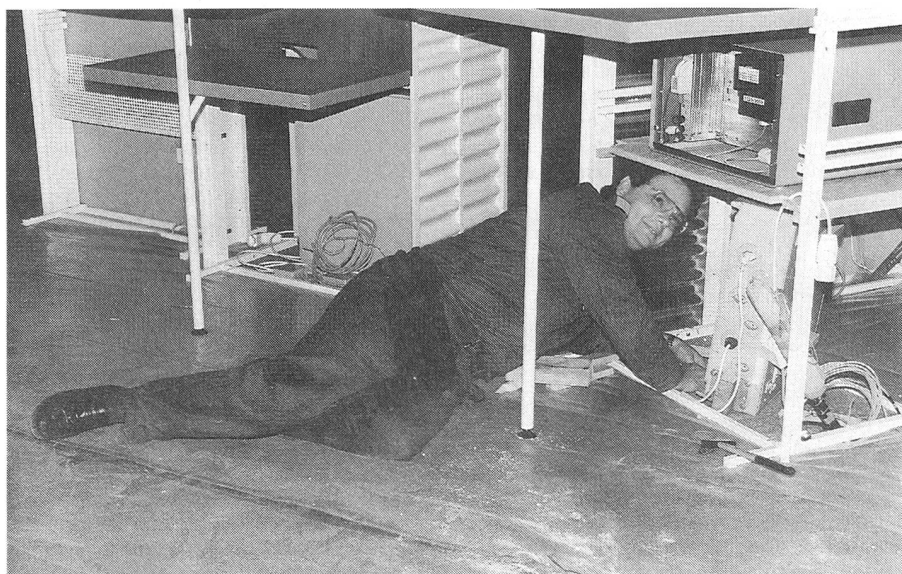
Gfr Henchoz, 1. Zug, führt im Pavillon Suisse Kabelarbeiten aus.
