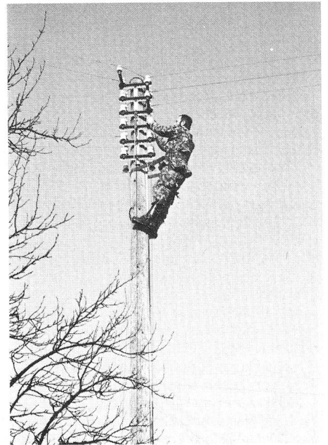
Immer noch aktuell: Der Telegrafienpionier beim Leitungsbau. Bild: BAUEM
