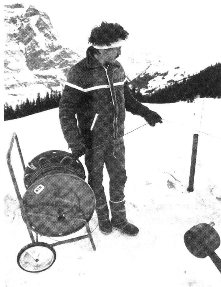
Erstmals setzte das Schweizer Fernsehen DRS am Lauberhornrennen Glasfaserstrecken für Bild- und Tonübertragung ein.
