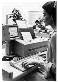
Sowohl als elektrische Schreibmaschine, elektronische Speicherschreibmaschine und vor allem als Übertragungsstation für die elektronische Textkommunikation können die neuen Textstationen von Siemens fungieren. Die für den von der Deutschen Bundespost geplanten Teletex-Dienst entwickelten Textstationen gibt es wahlweise mit Typen- oder Tintendruckwerk sowie mit oder ohne Bildschirmzusatz.
