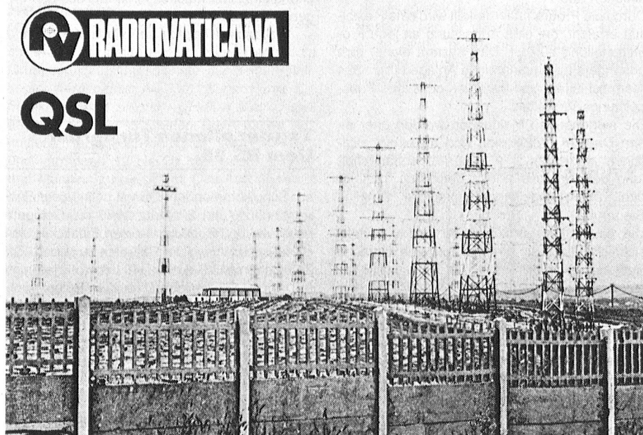
Santa Maria di Galeria: Une partie des antennes ondes courtes; à gauche mât en forme de croix pour supporter les antennes directionnelles assurant différents ponts radio.
