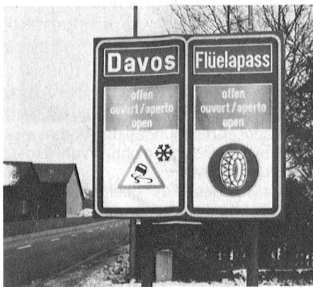
Bild 4: Das Doppel-Wechselsignal in Landquart, konstruiert nach dem Bandprinzip
