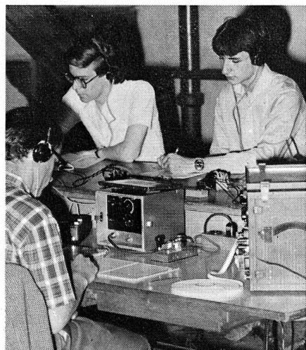
Im traditionellen Morsekurs (Kurstyp A) werden heute neben dem Streifenaufzeichnungsgerät (rechts im Bild) Kassettengeräte mit vorbereiteten Uebungstexten für das Gehöralesen eingesetzt. (Bild sp) De nos jours des lecteurs de cassettes avec des textes d'exercices préenregistrés sont utilisés dans les cours de Morse (cours A). A droite un enregistreur des signaux Morse sur bande de papier.
