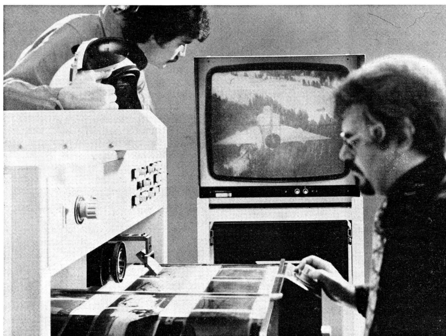
Das elektronische Auswertegerät REVI II: Im Vordergrund das Durchleucht-pult mit den Filmführungen, im Hintergrund der Bildmonitor
