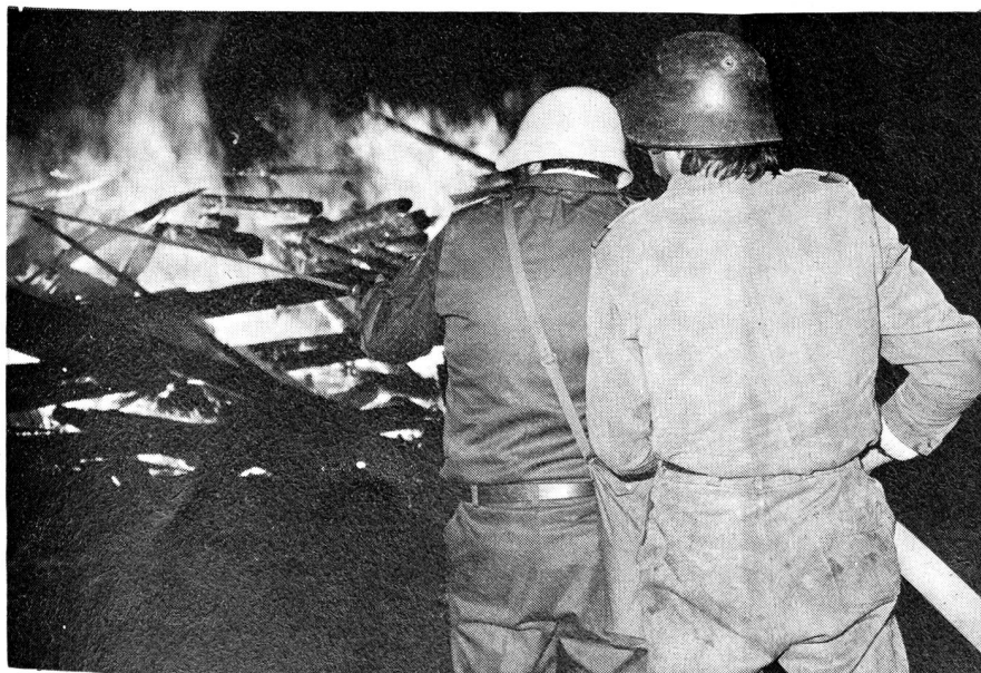
Schadenplatz in Küsnacht: Erstmals hatte der Zivilschutz Gelegenheit, im Rahmen der Gesamtverteidigungsübung «Knacknuss» an realistischen Uebungsanlagen zu arbeiten. (Aufnahmen: Hansjörg Spring)
