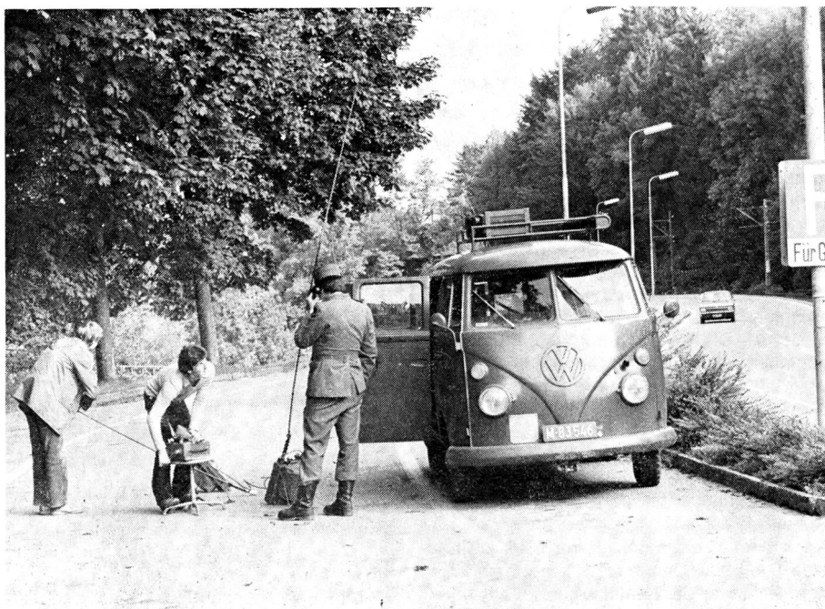
Mit dem Handgeneratorenbetrieb erzielt man bei der Funkstation SE-208 die 3-fache Leistung gegenüber dem Batteriebetrieb
