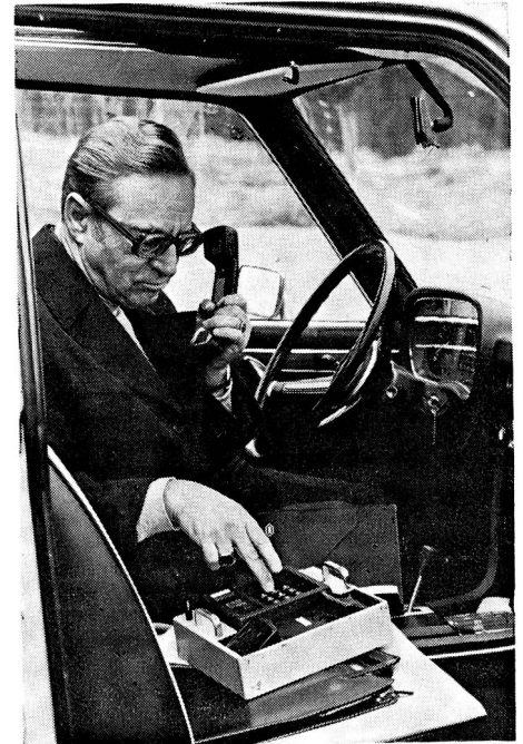
Das tragbare NATEL kann portabel in Fahrzeugen verwendet werden, wenn man nicht im voraus das Gerät in ein bestimmtes Fahrzeug einbauen will.
