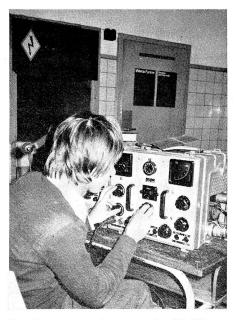
Das Frequenzwechseln an der SE-222 erfordert technisches Geschick
