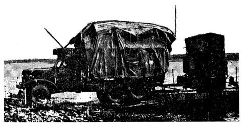
Funkmess-Station der Truppenluftabwehr auf dem Marsch. Im Zweiradanhänger befindet sich das Reservestromaggregat. Die Antennenanlage ist abgeklappt auf dem Dach des Stationsfahrzeuges gelagert.
