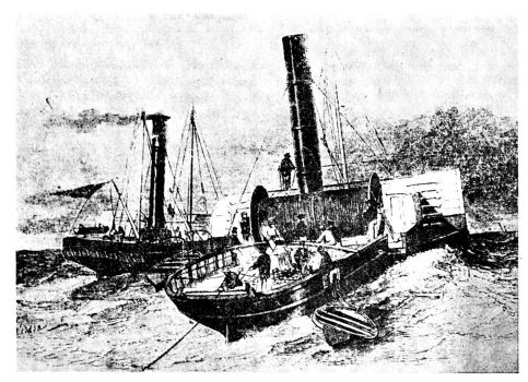
Der britische Schlepper «Goliath» verlegt das erste unterseeische Seekabel im Jahre 1850 zwischen England und Frankreich. Er wird begleitet vom Schlepper H. M. Widgeon. Beide Schiffe befinden sich in der Mitte des englischen Kanals.
