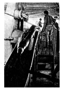
Verstärker und Kabel werden über eine Rampe des Kabellegers im Meer versenkt.
