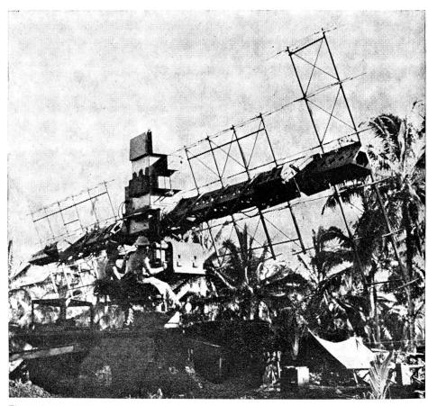
Ein typisches Radargerät aus dem Jahre 1943. Es wurde von der US Army und US Air Force zur Ortung von Luftzielen verwendet.
