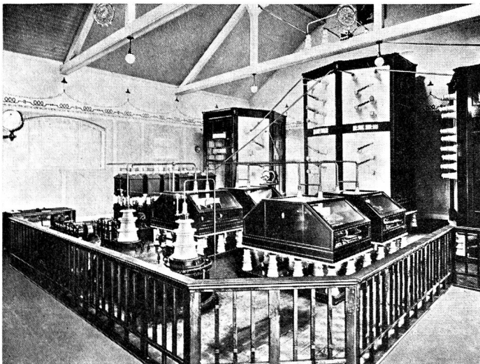
Fig. 26 Tönender Löschfunksender der Sendestation Nauen in den Jahren 1909–1911.
