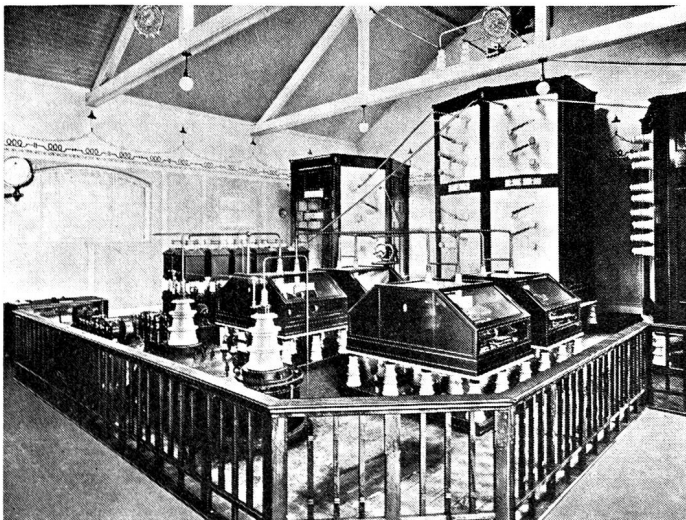
Fig. 26 Tönender Löschfunktensender der Sendestation Nauen in den Jahren 1909–1911.
