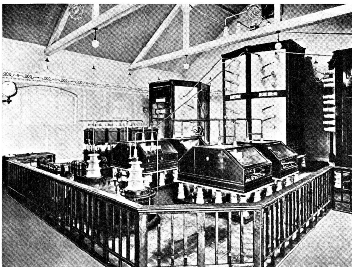
Fig. 26 Tönender Löschkensender der Sendestation Nauen in den Jahren 1909–1911.
