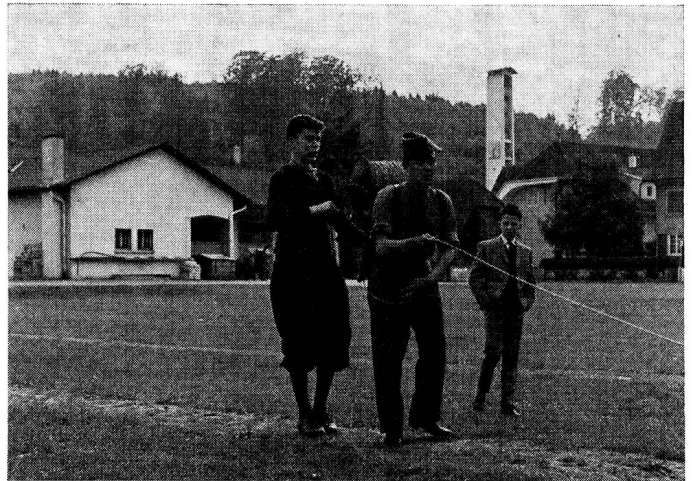
In vielen KP wurden für Jungmitglieder spezielle Übungen vorbereitet. Allerdings dürfte den jungen Leuten auch die Mithilfe beim Leitungsbau nicht schaden!
