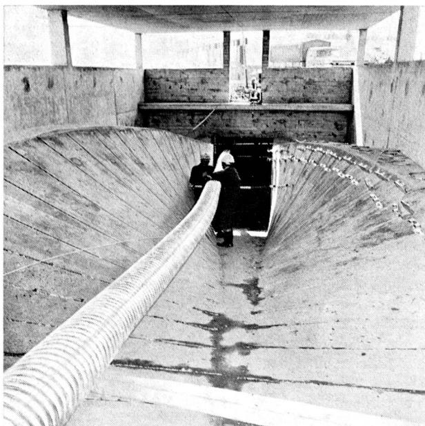
Verlegen des Kabels in begehbaren unterirdischen Kanälen im Gelände der neuen Kurzwellensendeanlage der «Deutschen Welle» bei Ettringen. Im Endausbau soll die Anlage über 12 Sender mit einer Leistung von je 500 kW verfügen.
