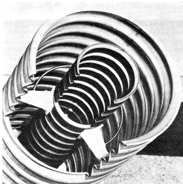
Das dickste Hochfrequenzkoaxialkabel der Welt besteht aus einem ringförmig gewellten Kupferrohr von 99 mm Durchmesser als Innenleiter und einem spiral gewellten Aluminiumrohr mit einem Durchmesser von 246 mm als Außenleiter. Für die Zentrierung des Innenleiters im Außenleiter sorgen Isolierstützen aus Du Pont Teflon FEP, die auf einem offenen kupferplattierten Stahlring fixiert sind.
