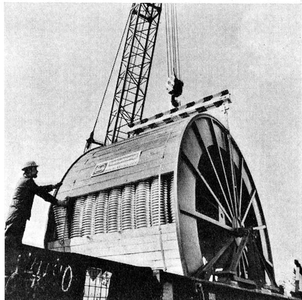
Verladen des dicksten Hochfrequenzkoaxialkabels der Welt von einem Tiefladewagen. Wellungen am Innen- und Außenleiter ermöglichen das Aufwickeln des Kabels auf Spezialtrommeln von 4,5 m Durchmesser.
