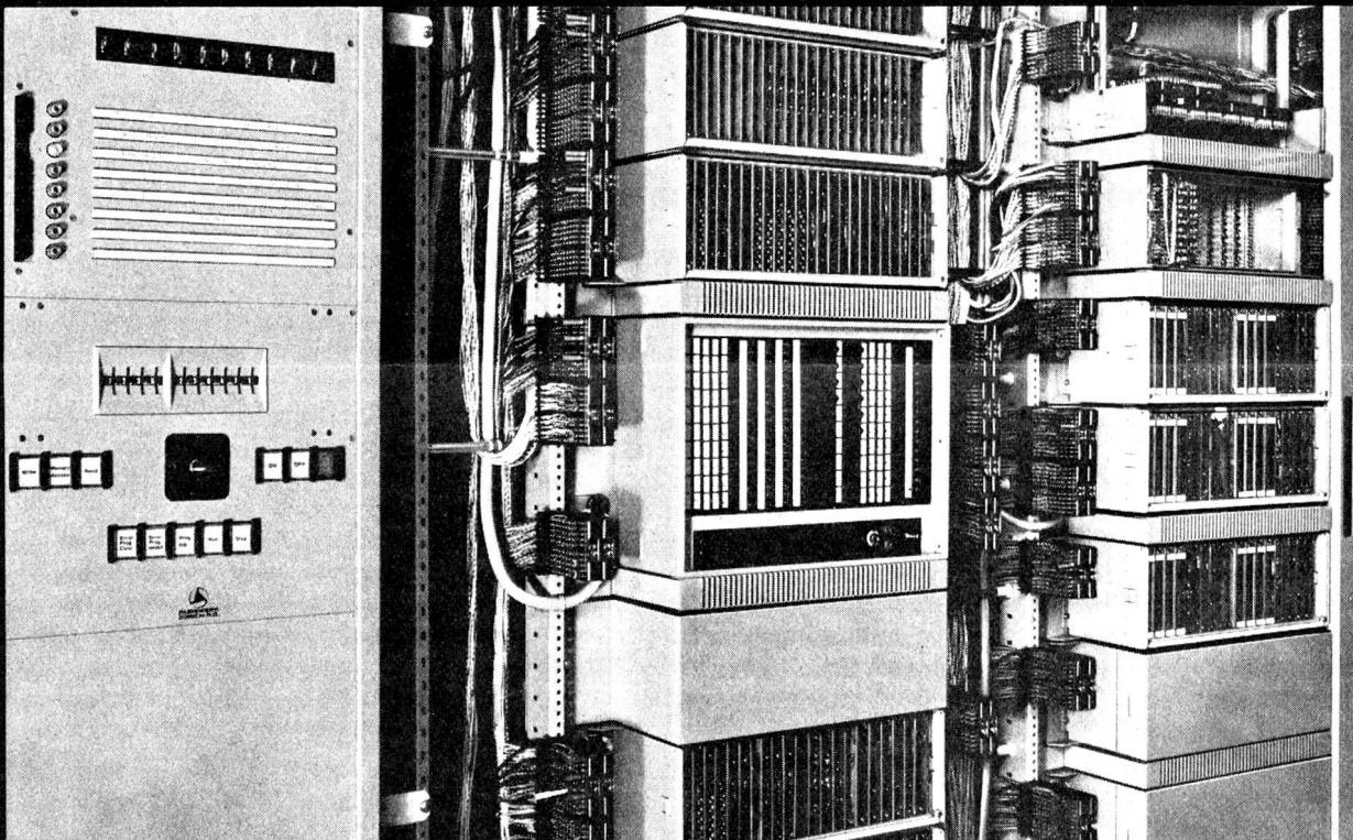
In enger Zusammenarbeit mit der GD PTT und der Kreistelephondirektion Basel entstand im TT-Neubau an der Wallstrasse ein neues nationales Fernwählamt ESK A 60 S/A 62 S. Dieses arbeitet mit Edelmetall-Schnellkontakt-(ESK) Relais und elektronischen Bauelementen.
