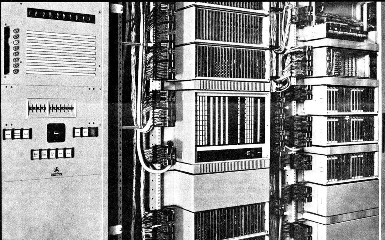
In enger Zusammenarbeit mit der GD PTT und der Kreistelephondirektion Basel entstand im TT-Neubau an der Wallstrasse ein neues nationales Fernwählamt ESK A 60 S/A 62 S. Dieses arbeitet mit Edelmetall-Schnellkontakt-(ESK) Relais und elektronischen Bauelementen.
