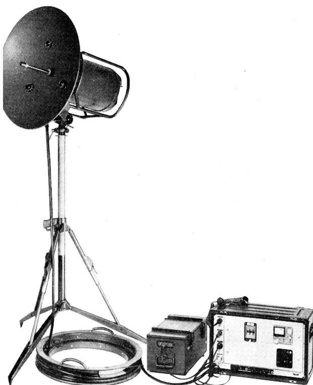
Fig. 1 Richtstrahlstation R-902, betriebsfertig aufgestellt Links: Sende-Empfangsgerät auf Armeestativ Mitte: Speiseakkumulator 24 V Rechts: Bedienungsgerät, geöffnet. Mikrorel für Dienstka- nalbesprechung angeschaltet. Mitte oben Kanalwahlschal- ter, rechts Überwachung mit Dienstkanal und Netzteil-Part.
