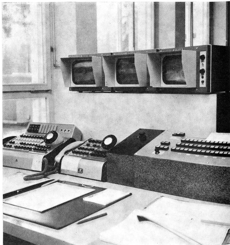
Polizeizentrale Süd mit dem provisorisch installierten Bedienungspult (rechts) und den drei Monitoren
