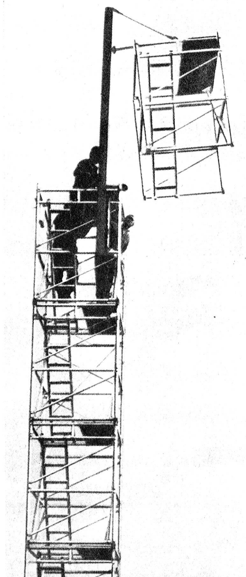
Fig. 7: Aufbau eines «Hi-way»-Antennenträgers. Jede der zusammenlegbaren Gerüst-Etagen passt bis zur Höhe von 60 Metern auf die andere.
