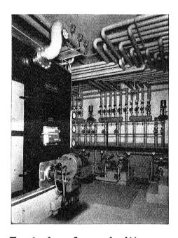
**Zentralen-Ausschnitt** einer Wärme-Speicher-Heizungs-Anlage Leistung: 1200 000 kcal/h
