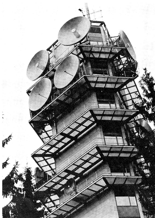
Fig. 6. Richtstrahlantennen für Telephonie, internationale Fernsehverbindungen und den Programmaustausch des Schweizer Fernsehens in Zürich mit den Studios in Genf und Lugano sowie zu den Fernseh-Hauptsendern der deutschen Schweiz
