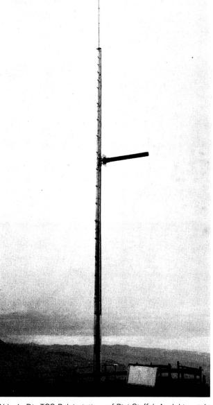
Abb. 4. Die TCS-Relaisstation auf Rigi-Staffel. Auch hier steht ein 18-m-Mast mit einem Rundstrahler an der Spitze und der kanonenförmigen Helix-Richtstrahlantenne, die Richtung Zürich zeigt. Die Gerätekabine wurde aus dem Felsen herausgesprengt. Rechts erkennt man den geöffneten Einstiegdeckel.
