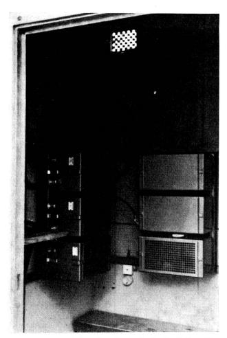
Abb. 3. Blick durch die offene Tür in die Geräte-Kabine. Man erkennt links Sende-Empfangs- und Speisegerät der Richtfunkanlage, rechts die gleichen Geräte des Ortssenders. Bei allen ortsfesten Geräten handelt es sich um Geräte und Installationen der Firma Brown, Boveri AG Baden.
