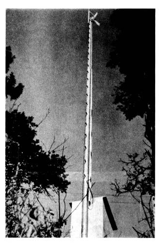
Abb. 2. Die Relaisstation Châtel befindet sich auf einer Juraterrasse auf ca. 900 m Höhe. Der 18 m hohe Mast trägt eine Rundstrahlantenne, die die Mitteilungen an die Patrouilleurwagen im Raume Genf—Yverdon—St. Maurice im 80-MHz-Band ausstrahlt und eine Winkelreflektorantenne, welche die Richtfunkverbindung mit der Zentrale Lausanne (410-MHz-Band) sicherstellt. In der Kabine sind die Geräte untergebracht.
