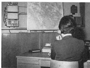
Abb. 8. Blick in die Telephon- und Funkzentrale Zürich. Die BBC-Funkgeräte (links oben ist einer der 3 Gerätesätze erkennbar) sind im oberen Wandkasten montiert und werden normalerweise von grossen Magnet-Kartentafeln verdeckt.
