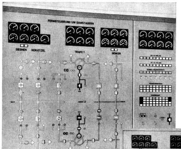
Von dieser Schalttafel aus wird in Zürich über eine ALBIS-Fernsteuerungs-Anlage das Unterwerk Samstagern ferngesteuert.
