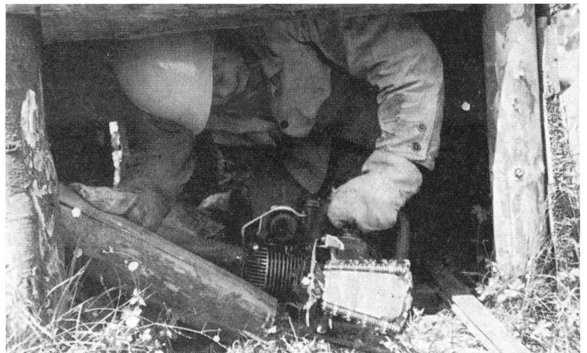
Handhabung der Geräte und Werkzeuge in beengten Verhältnissen. Einsatz der Motorkettensäge.
