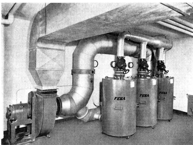
Ventilationsraum einer Sanitätshilfsstelle mit 3 Gasfiltern von je 600 m<sup>3</sup>/h,
