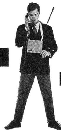
Das Kleinfunkgerät SE 18 der Autophon ist leicht, handlich, leistungsfähig. Es wiegt nur 2,6 kg. Es ist nur 19,8 cm breit, 16,6 cm hoch und 5,5 cm dick: etwa halb so gross wie ein Telefonbuch.
