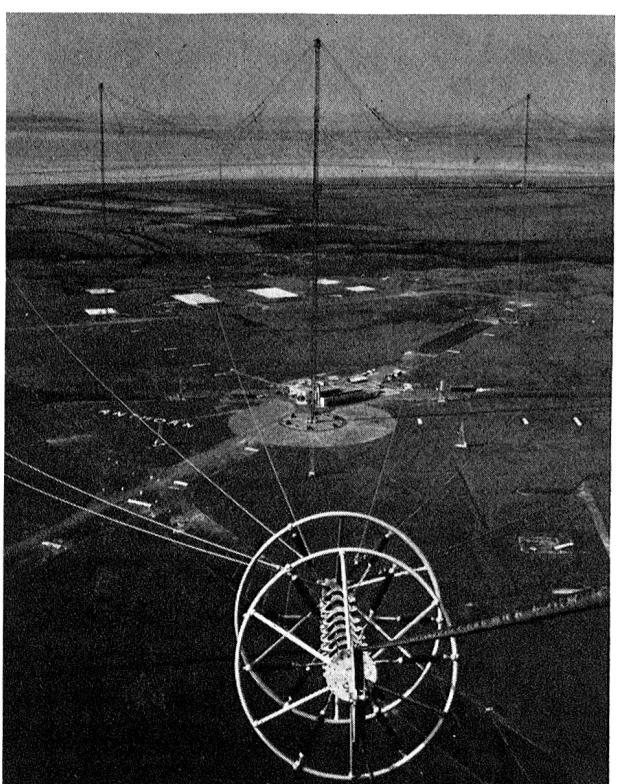
Blick auf die riesige Antennenanlage der VLF-Funkstation der NATO in Anthorn. Deutlich erkennbar ist noch die Landebahn des ehemaligen Flugplatzes, auf dem die Station errichtet wurde. In der Mitte des Bildes der Zentralmast und das Sendergebäude.
