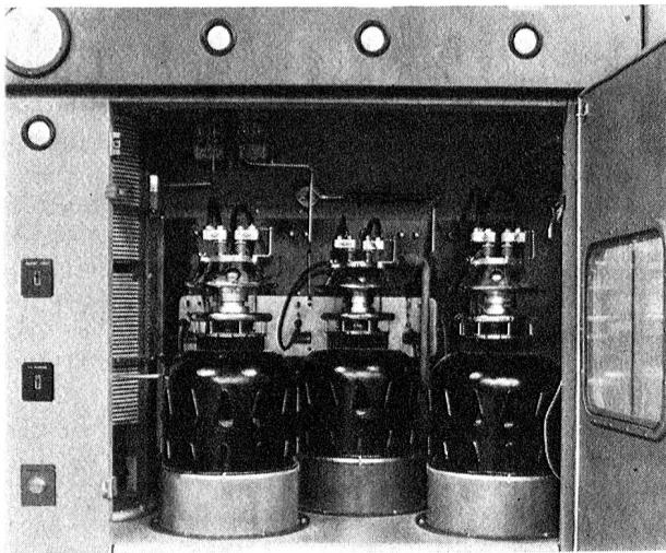
Die drei Hochleistungsröhren der Endstufe. Eine von ihnen dient als Ersatzröhre und lässt sich nach Auftreten einer Störung innerhalb von 60 Sekunden in Betrieb nehmen. Ein spezielles Sicherungssystem bietet die Gewähr, dass die Türen des Röhrenschrankes erst nach Abschalten aller gefährlichen Spannungen geöffnet werden können, um jede Gefahr für das Personal auszuschliessen.
