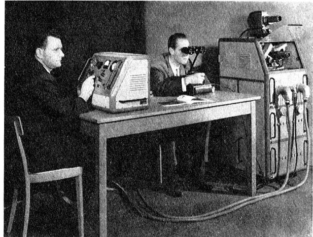
MOSQUITO-Trainingsanlage. Der Schütze lenkt mit seinem Lenkgerät die Lenkwaffe, welche durch einen Lichtpunkt vom Simulator auf eine Projektionswand dargestellt wird, nach den Weisungen seines Lehrers. Dieser kann am Kommandopult alle gewünschten Einflüsse wie z. B. Wind, Startwinkel, Zielgeschwindigkeit, Entfernung des Ziels usw. einstellen. Schon nach wenigen Übungsstunden an der Trainingsanlage ist der Schütze in der Lage, Lenkwaffen mit guter Trefferwartung zu starten.
