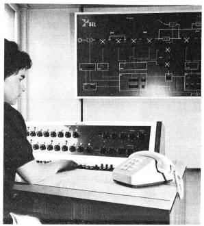
Abb. 3. Prüftisch und Anzeigetablo der quasi-elektronischen Fernsprech-Vermittlungsstelle Stuttgart.
