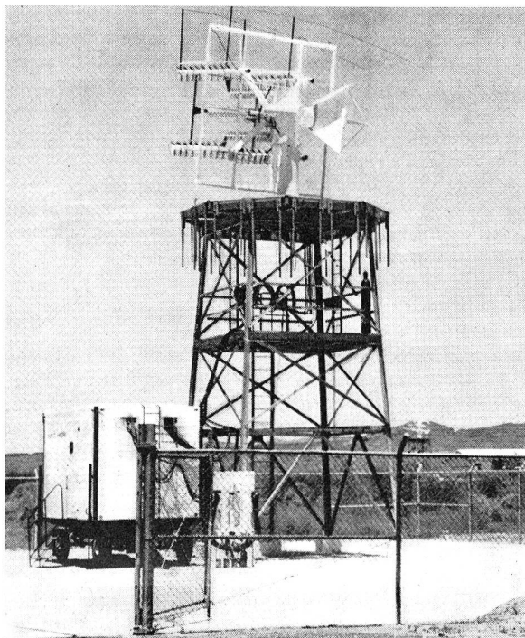
Vierfachwendel-Telemetrieantenne und fahrbares Stromversorgungsgerät der Mercury-Bahnverfolgungsstation Guaymas in Mexiko.
