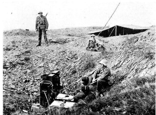
Abb. 34. Tragbare schwere Funkstation (TS) in Stellung.
