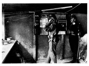
Abb. 17. Telephonzentrale mit Klappenschrank der TT-Verwaltung.
