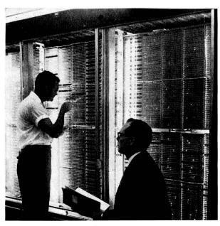
Teilansicht des elektronischen Telephonamtes in Morris (USA). Über die in den Gestellen reihenweise angeordneten Kaltkathodenröhren werden die Sprechwege durchgeschaltet. Die Lichtpunkte im rechten Gestell weisen auf gezündete Röhren, also auf durchgeschaltete Verbindungen, hin.
