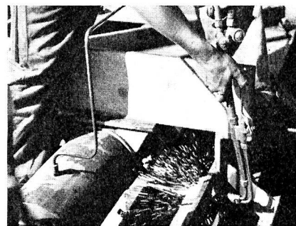
Lostrennung der Brücke vor der Verschiebung
