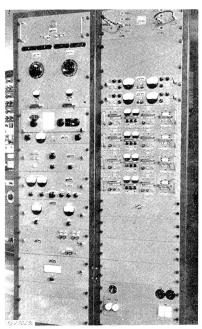
Fig. 16: RCA-SSB-Empfänger, (Empfangsstation Riedern)
